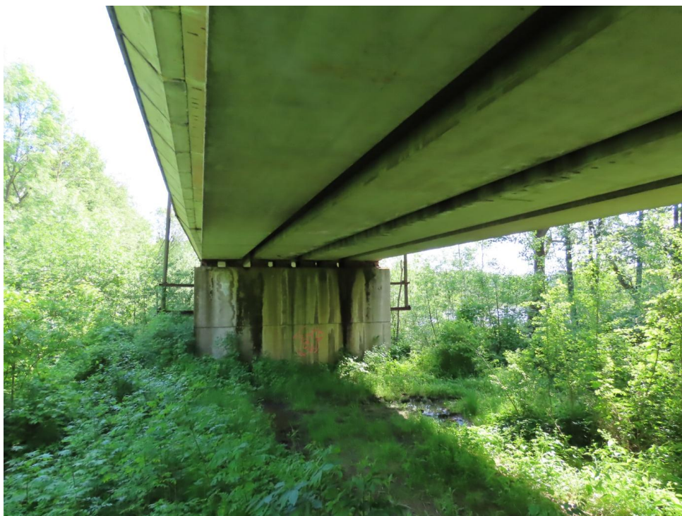
Zatékání na úložné prahy mezilehlých podpěr
