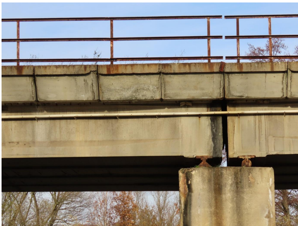
Uložení Nosné konstrukce na mezilehlých podpěrách
