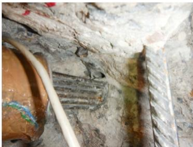
Zkušební místo EM3 - nezainjektovaná horní část kanálku
