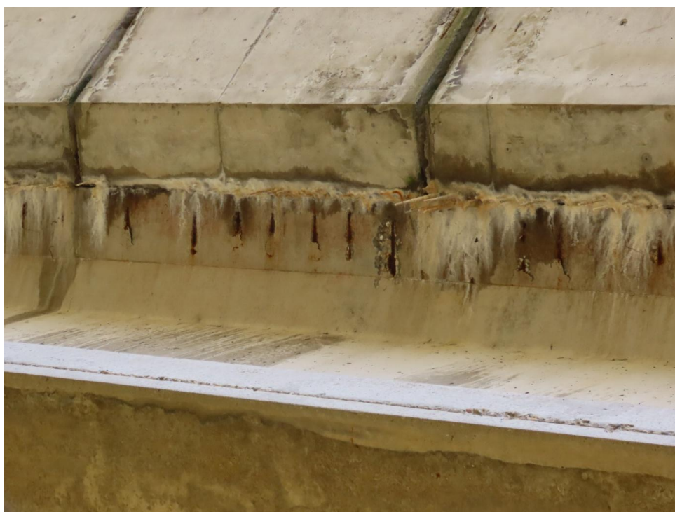
Zatékání v místě spojení KT24 nosníků a římsových prefabrikátů
