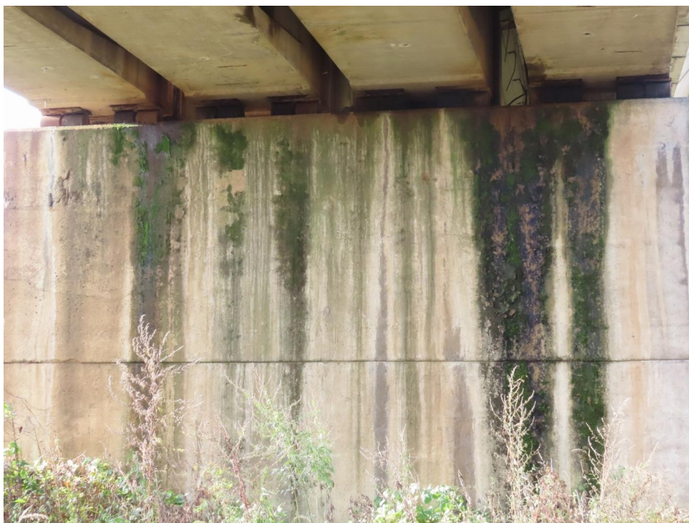
Zatékání na úložné prahy krajních opěr
